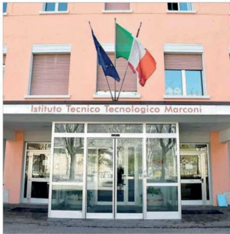
L'ingresso dell'istituto tecnico tecnologico Marconi che si trova a Sant'Ilario
