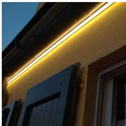
Per l'illuminazione del retro dell'abitazione è stato utilizzato il profilo Phi 17. Essendo un estruso dalla sezione circolare molto ridotta (17mm), si inserisce con discrezione nella piccola sporgenza della facciata. Questo corpo lampada può essere ruotato in maniera da non abbagliare l'osservatore ad una certa distanza. Anche l'ottica diffondente e la conformazione del profilo contribuiscono a non disturbare l'osservatore con la sorgente.
