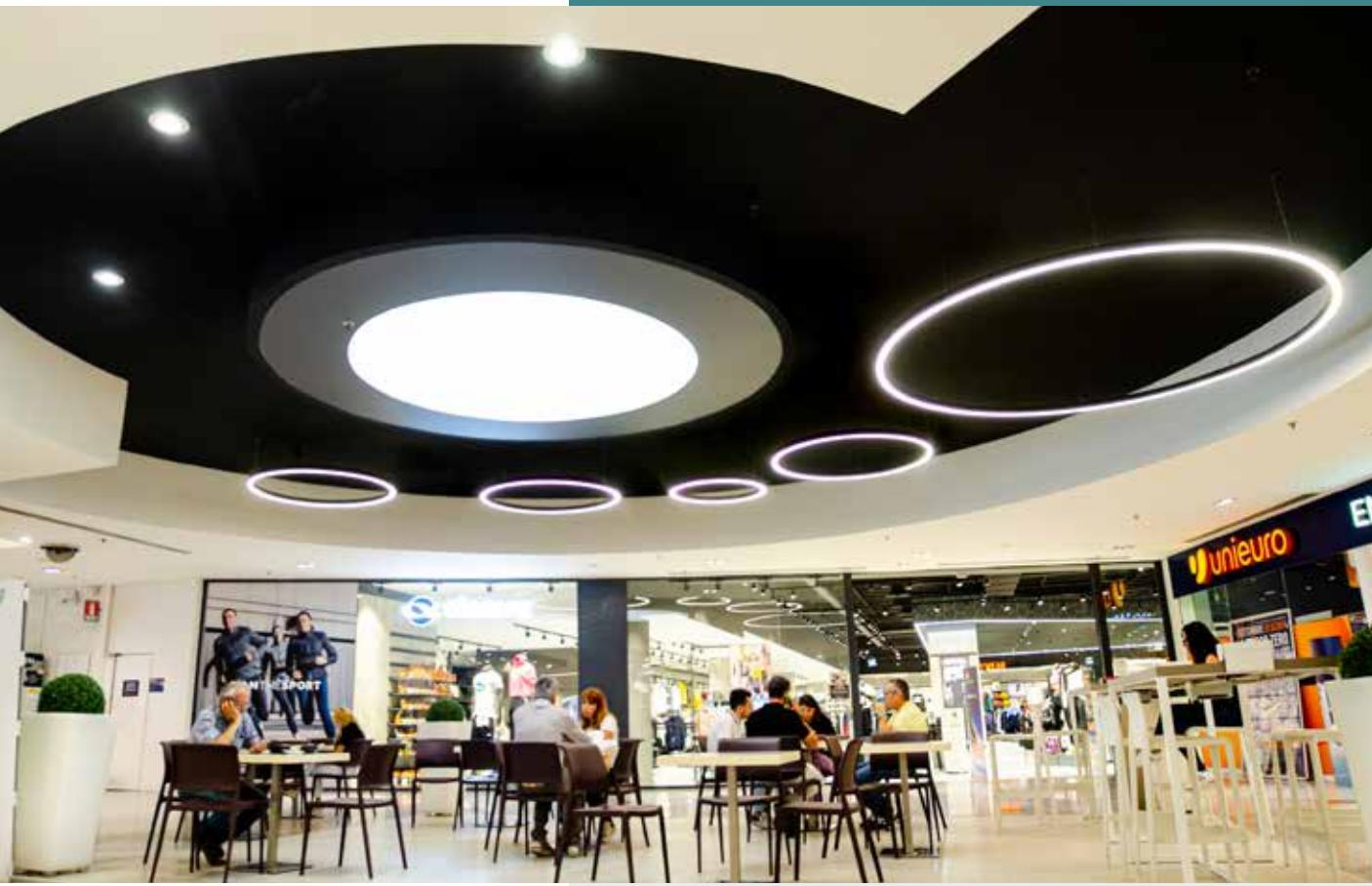
Grazie alla scelta della copertura opale in silicone, vi è un diffusore con un solo giunto, pur con uno sviluppo di 21 metri di lunghezza. Inoltre la cover opale siliconica con texture interna a 45° permette una diffusione ultraomogenea della luce ed un ottimo livello di riflessione.
