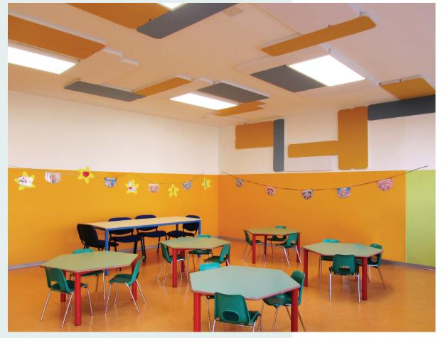
L'ambiente è stato ulteriormente migliorato con l'installazione di pannelli fonoassorbenti in sala mensa. Per la correzione acustica abbiamo utilizzato prodotti certificati con ottime proprietà fonoassorbenti in grado di ridurre il tempo di riverbero del suono.
